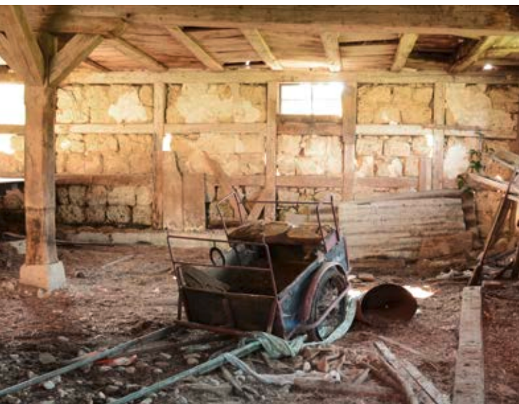
Das denkmalgeschützte Gebäude in seinem ursprünglichen Zustand
