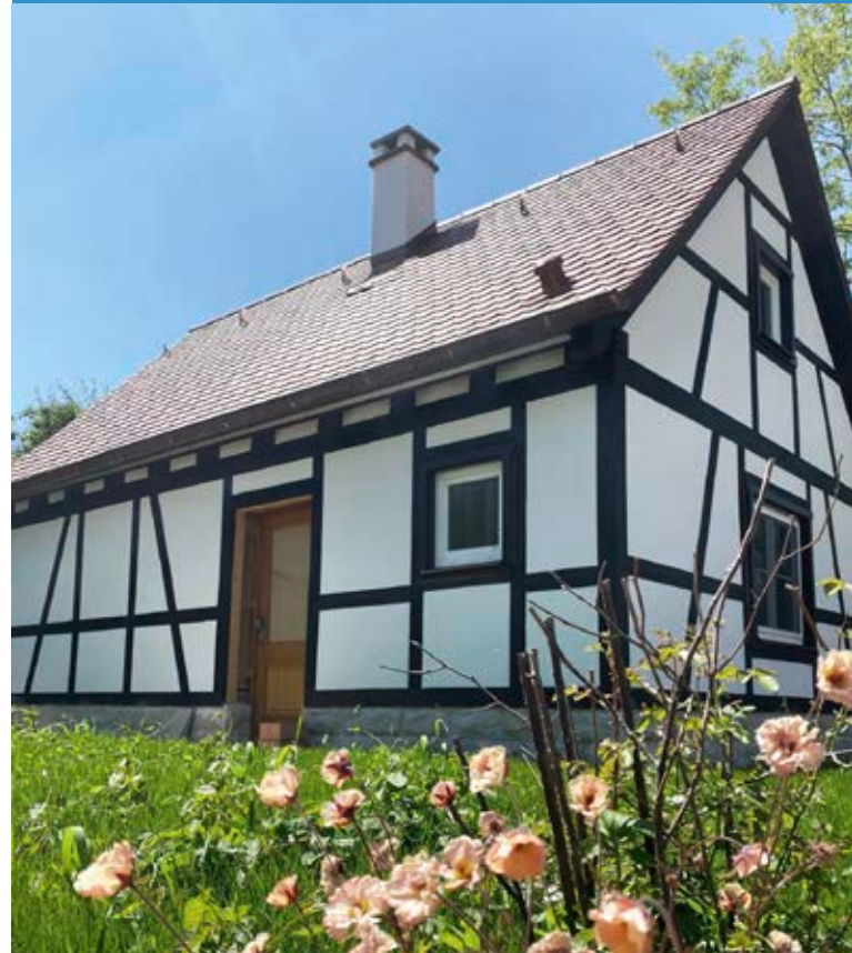
Raum für Jugendliche im historischen Gebäude
