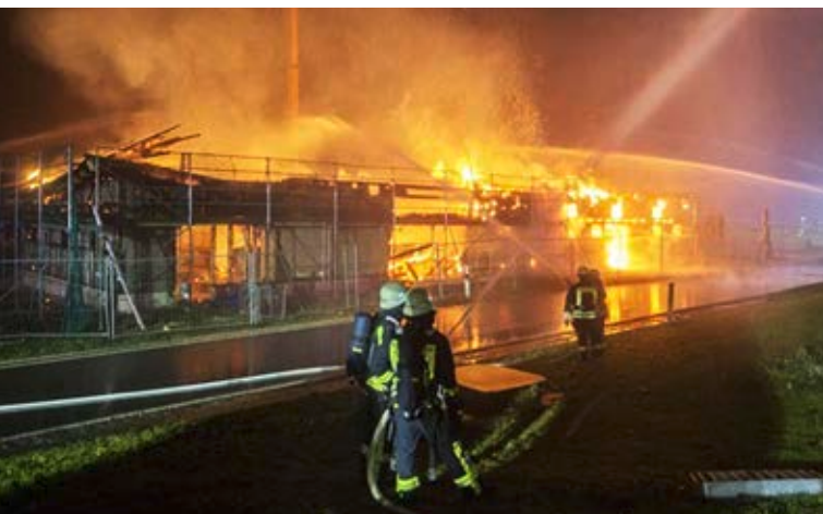
Das Feuer zerstörte das Gebäude, das gerade renoviert wurde, im November 2017 komplett
