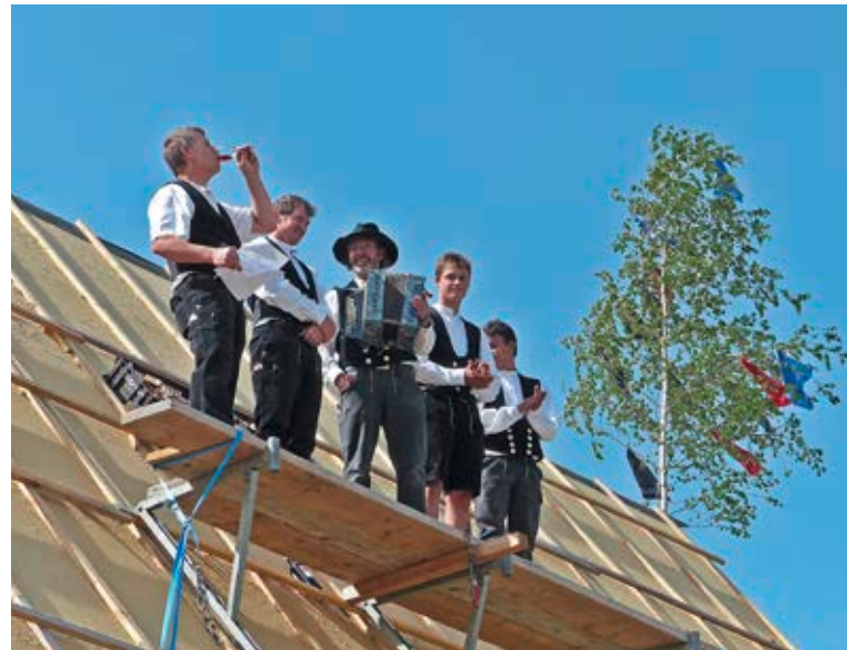
Erst im Sommer 2017 war das Richtfest für das neue Dach gefeiert worden
